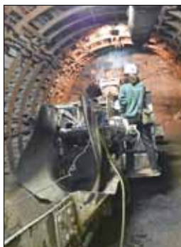
Vorführung einer Vortriebmaschine unter Tage
