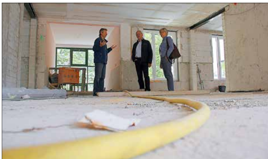
Frank Parreidt (links) erläuterte Oberbürgermeister Bernd Hauschild und Baudezernentin Ina Rauer Ende Mai vor Ort den aktuellen Stand der Arbeiten. Foto: Niemand
