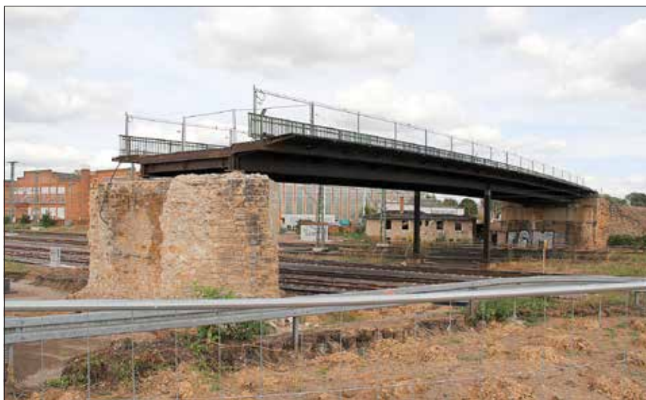
Aus der „Hohen Brücke“ war Mitte August eine „Hohe Rampe“ geworden.
