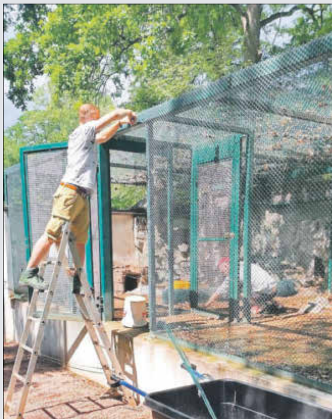
Die Arbeiten am Tiergehege sind in vollem Gange.
