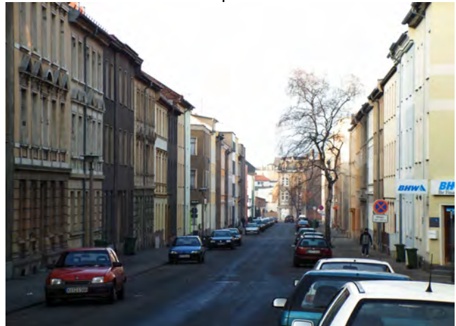
Unsanierter Altbauzeile in der Ludwigstraße
