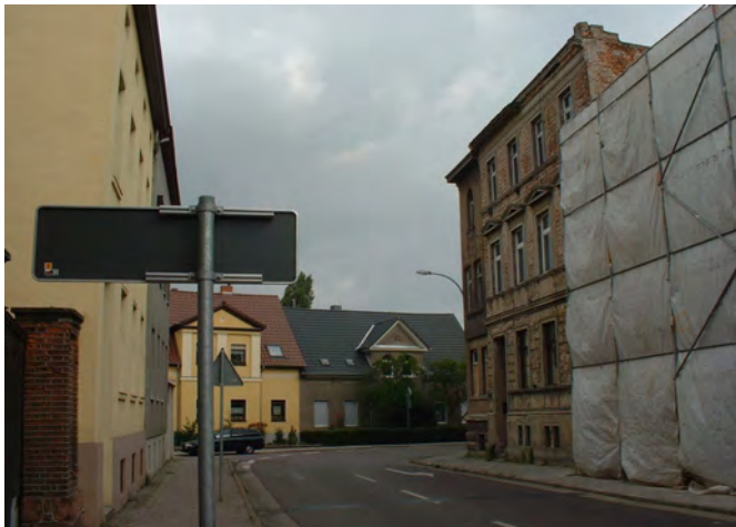
Gefährdete Bebauung in der Langen Straße
