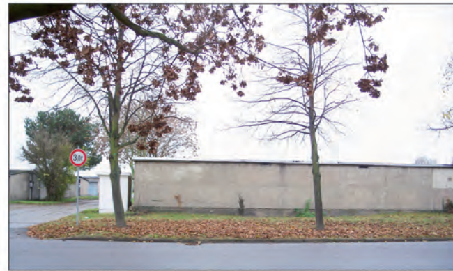
Garagen an der „Anhaltischen Straße“- Blick von der Straße
