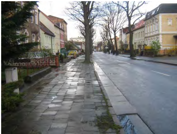
Bild 19: Leopoldstraße Richtung Westen (vor der Sanierung)
