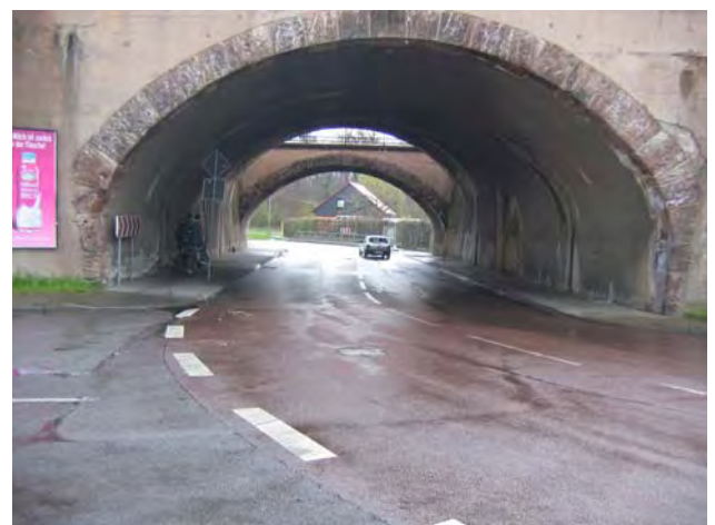
Bild 24: Bahnunterführung Dessauer Straße
