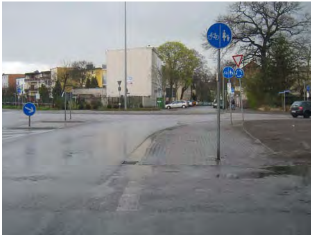
Bild 21: Kreisverkehrsplatz Leopoldstraße / Dessauer Straße
