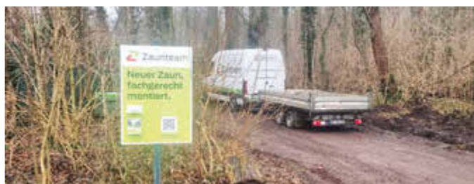
Die Bauarbeiten am Außenzaun schreiten voran
